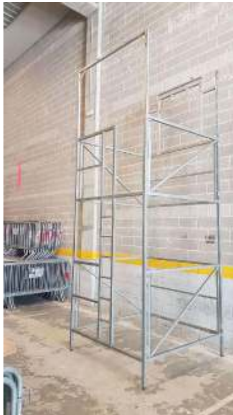
Imagen 2 : escalera de ascenso
